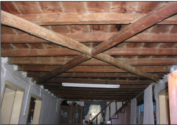
Resim 12: Zemin kat tavan kiriş sistemi
