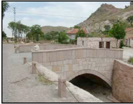
Şekil 9. Taş Köprü ve Sille Çayı Köprüsü (Orijinal 2013)
